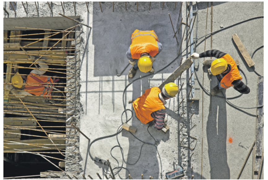
Die ZPK Save ist für Kontrollen auf den Baustellen verantwortlich. (Foto: SSI)
