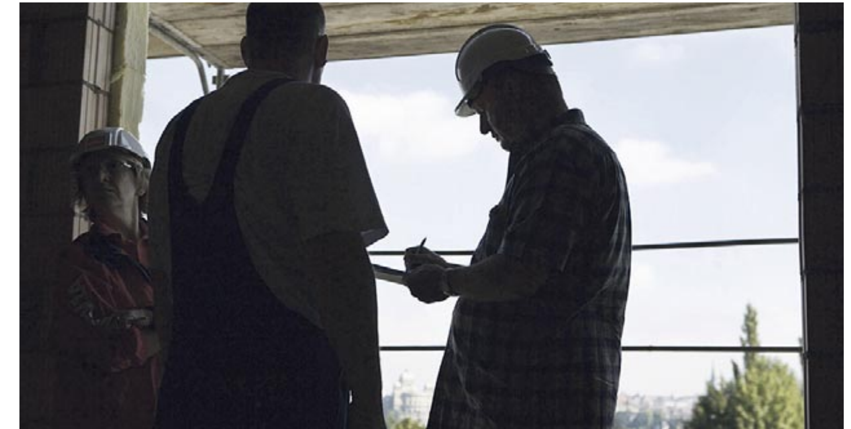
Auf einer Baustelle findet eine Kontrolle statt.
